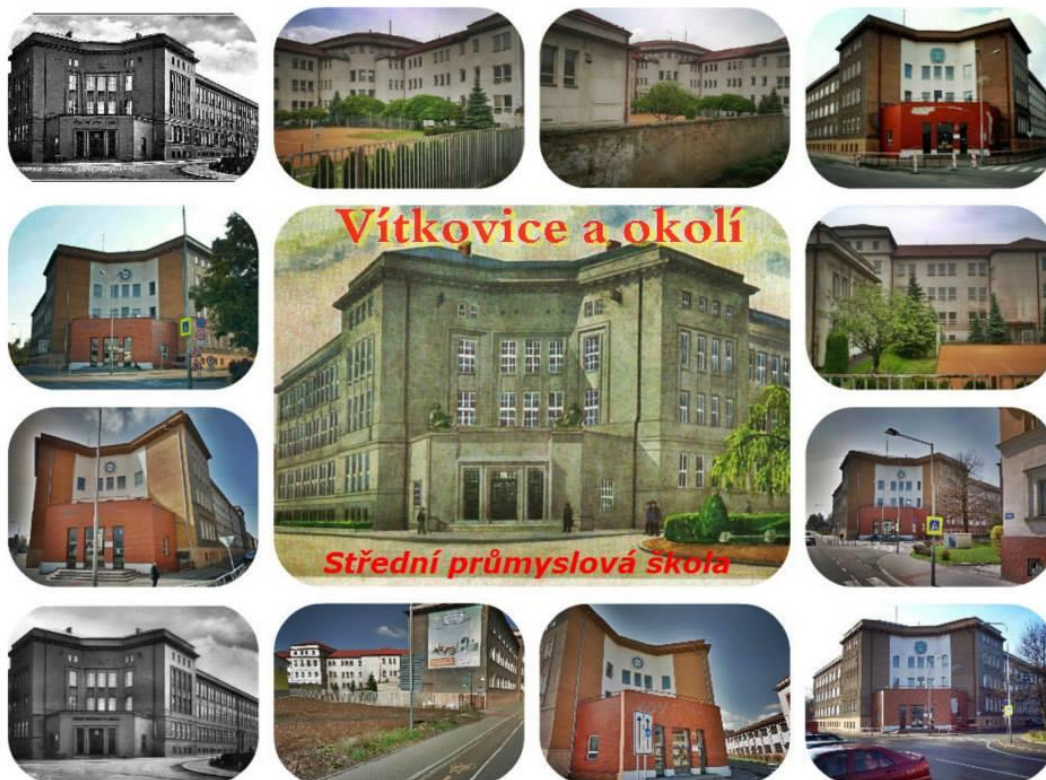
Historické fotografie budovy školy
